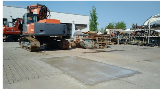
Fertiggestellte Fläche, ca. 3mm dick
