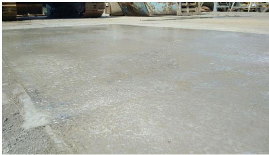
Beschichtung mit „SysCo-SVi“ und Stahldrahtfasern
