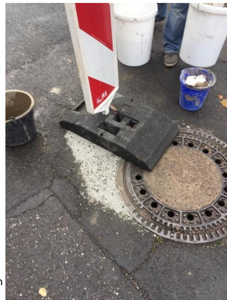
Absanden und 2 Tage Bereich sperren
