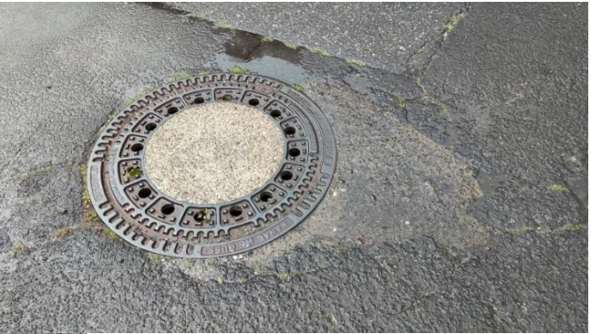
2023: Aktuelles Foto der Nutzfläche ohne Schäden
