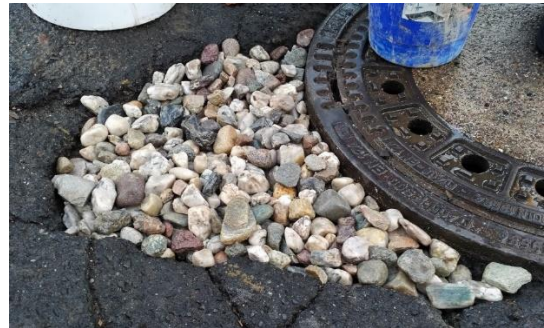
Kiesel bis OK einfüllen und anfeuchten
