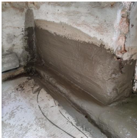
Beschichtung Sockel mit „SysCo-SCASS“
