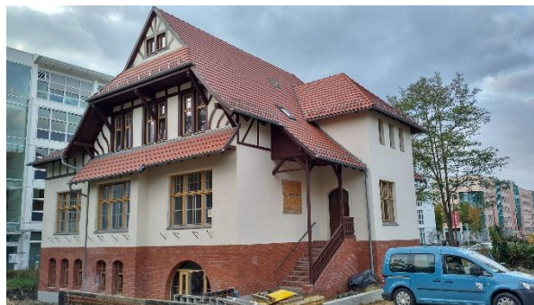
Beschichtung Sockel mit „SysCo-SCASS“
