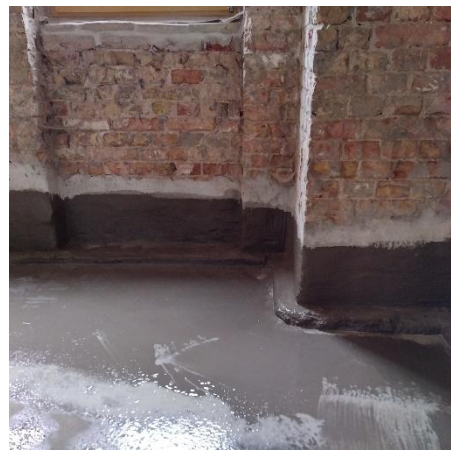
Beschichtung Boden mit „SysCo-SCASS“
