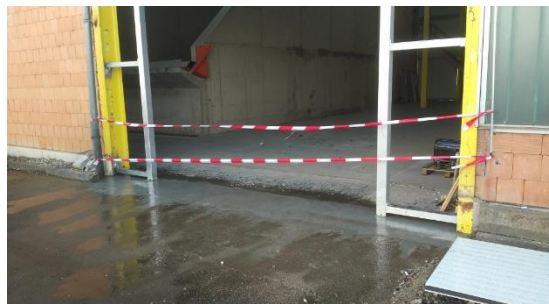
Fläche 1x pro Tag befeuchtet
