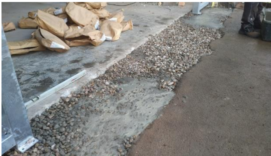
Kiesel wurden schichtweise ausgegossen
