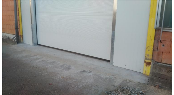
Aktuelles Foto der Nutzfläche ohne Schäden
