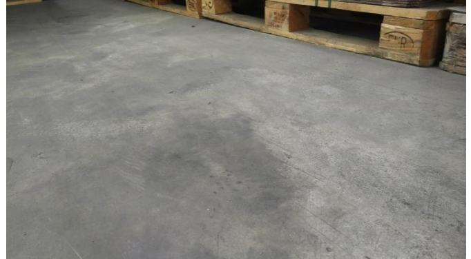
Aktuelles Foto der Nutzfläche ohne Schäden
