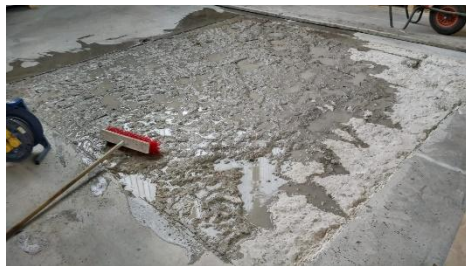
Wässern der Beschichtungsfläche
