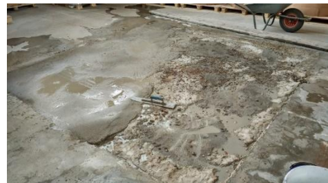
Erstbeschichtung mit „SysCo-SCASS-LF ready“
